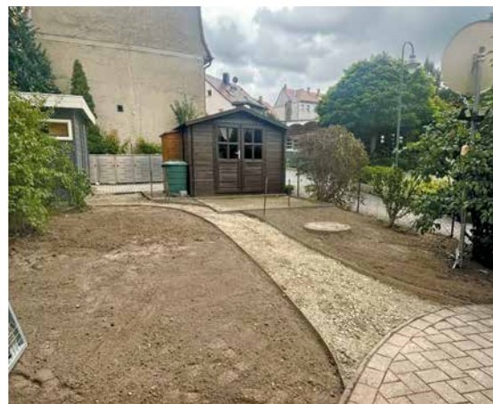
Nachdem vorhandenes Gestrüpp beseitigt und der Boden geebnet wurde, ist die Außenanlage bereit für die Bepflanzung.
