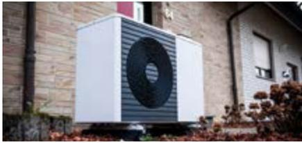
Luft-Wärmepumpen sind eine beliebte Alternative zur klassischen Heizungsanlage. Sie sind umweltfreundlich, können aber durch Ventilatoren, Verdichter und Rohrleitungen deutliche Geräusche verursachen. Mit zunehmendem Einsatz mehren sich auch Anfragen zu Lärmbelästigungen – vor allem in dicht besiedelten Wohngebieten.
