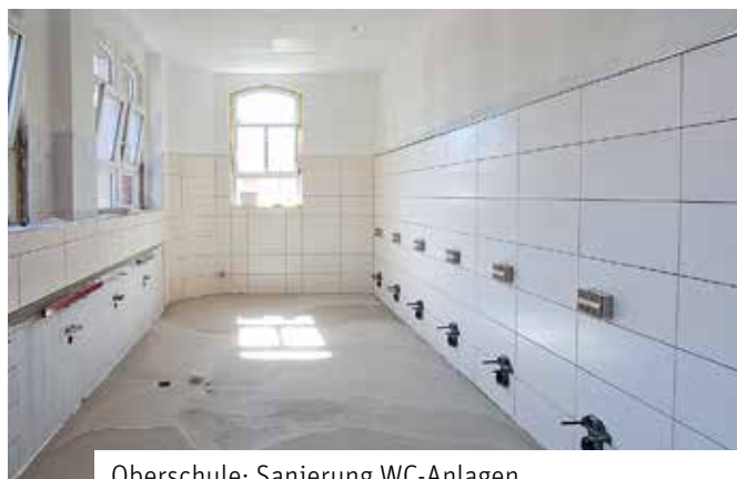
Oberschule: Sanierung WC-Anlagen
