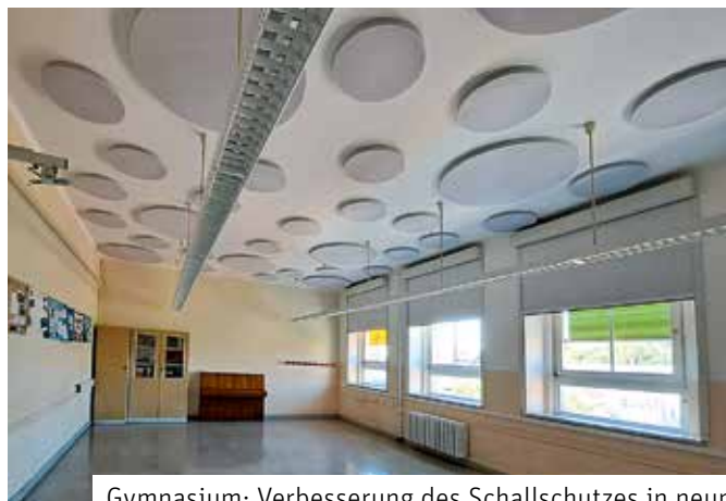
Gymnasium: Verbesserung des Schallschutzes in neun Klassenzimmern
