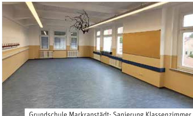
Grundschule Markranstädt: Sanierung Klassenzimmer
