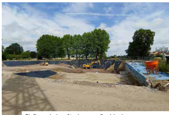
Tiefbauarbeiten für das neue Stadtbad
