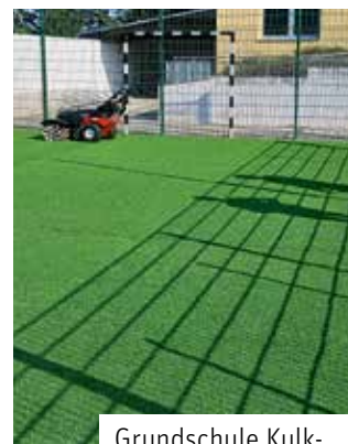
Grundschule Kulkwitz: Erneuerung Belag Bolzplatz
