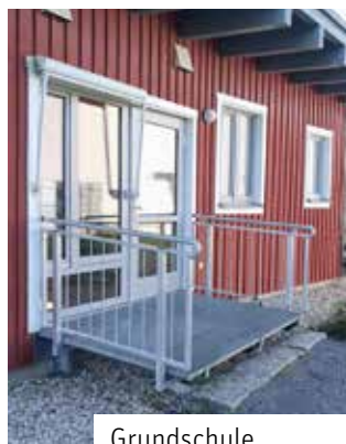
Grundschule Großlehna: Montage Geländer
