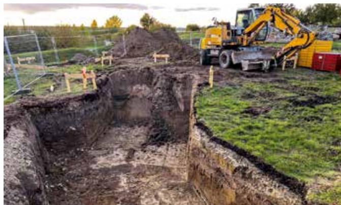
Für die zusätzlichen Stützen der Kletteranlage musste zunächst eine große Menge Erde ausgehoben werden.
