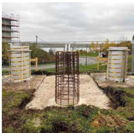
Auch die Sockelfundamente wurden betoniert.
