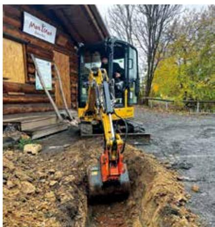
Anlegen einer Kabeltrasse für das neue Solardach auf der Kletterhütte.
