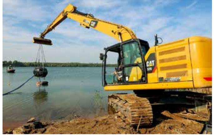
Ein außergewöhnlicher Bauabschnitt an der Jugendherberge am Markkleeberger See ist absolviert. Anfang September haben Mitarbeiter unter Federführung der Firma ITS Naumburg den letzten von elf Wärmetauschern im See eingebaut. Die Module sorgen dafür, dass die Jugendherberge mit Wärme versorgt werden kann.
