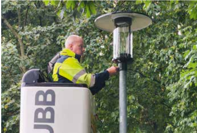
Die letzten Natriumdampflampen gingen vom Netz. Ab sofort wird Markkleeberg vollständig von moderner LED-Technik beleuchtet. (Foto: Daniel Kreusch)
