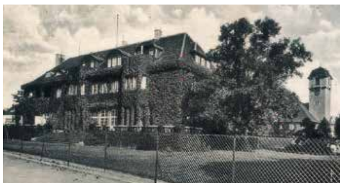
Obwohl vor über 80 Jahren aufgenommen, entspricht die Absperrung einem heutigen Maschendrahtzaun.
