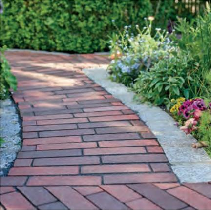
Pflasterklinker lassen sich versickerungsfähig verlegen, sodass Regenwasser direkt in den Untergrund versickern, Überschwemmungen verhindern und zum Grundwasserspiegel beitragen kann. (Foto: Arbeitsgemeinschaft Pflasterklinker e.V./GIMA/Alexander Bernhard/akz-o)
