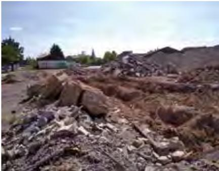
Der gesamte alte Gebäudebestand wurde vollständig abgebrochen und vor Ort in einer Brechanlage zerkleinert. Diese Materialien werden nun schrittweise abgefahren und fachgerecht entsorgt.
