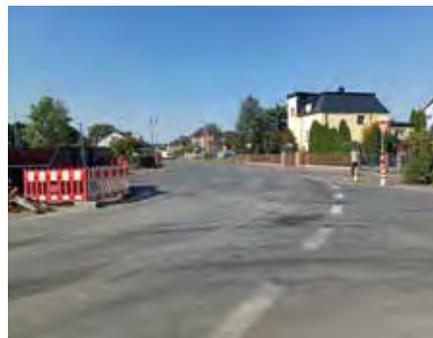
Mit dem Einbau der Asphaltdecke findet die Fertigstellung des 2. Bauabschnittes statt. Parallel werden noch die Restflächen im Gehwegbereich mit Betonverbundpflaster geschlossen.
