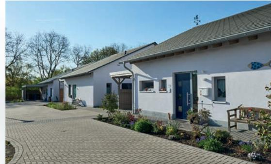
Massive Einfamilienhäuser aus Leichtbeton-Mauerwerk: Rein mineralische Leichtbeton-Wände gelten als „nicht brennbar“ und vermindern die Verbreitung von Rauchgasen. (Fotos: djd/KLB Klimaleichtblock)
