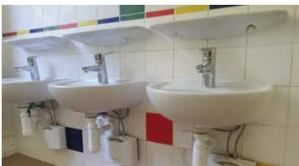
Die Kita Waldwichtel treibt ihre energetische Sanierung konsequent voran: Ab sofort wird die bisher zentrale Warmwasserversorgung durch eine dezentrale Lösung ersetzt. Der 9-wöchige Umbau zielte darauf ab, Betriebskosten zu senken, die Versorgungssicherheit zu erhöhen und
