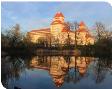
Blick vom Gura-See zur Mühle – einst sollten es sogar drei große Mühlengebäude werden (Frank Thomas)
