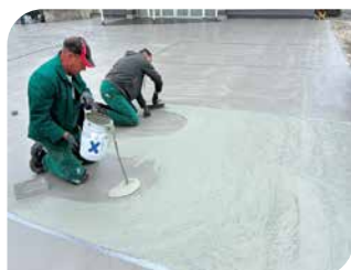
Abdichtung der Tiefgarage in der Schillerstraße
