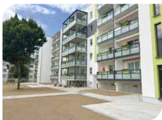
Fertig! Der Innenhof am Haus Theodor-Körner-Straße 90 – 100
