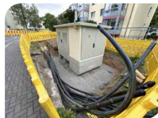
Neue Trafostation in der Georg-Schumann-Straße
