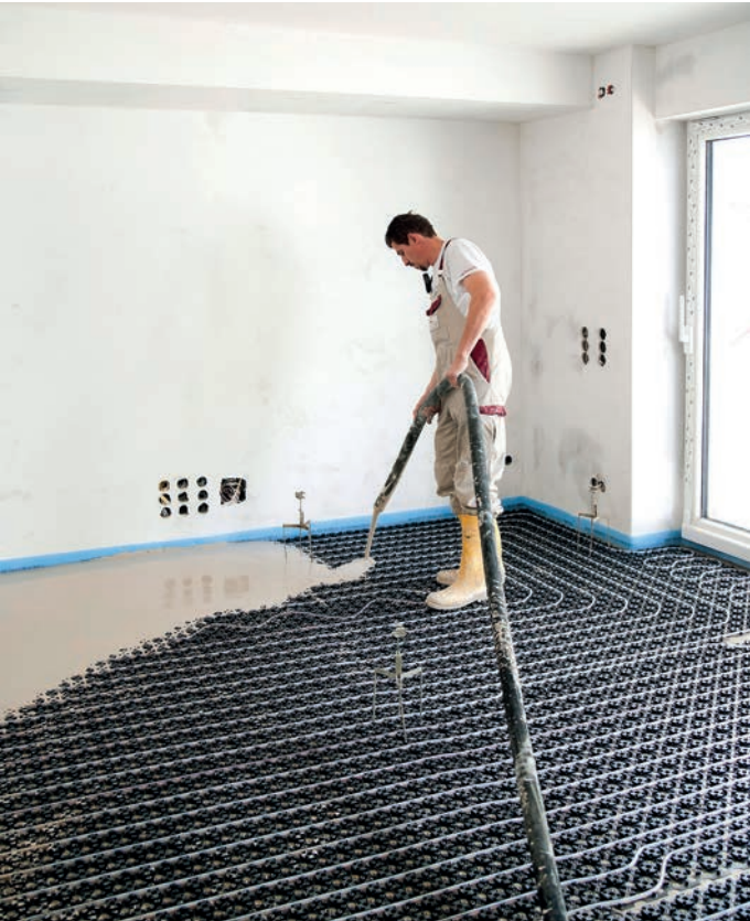
Spezielle Materialien wie Fließestrich erleichtern den Umstieg auf eine Fußbodenheizung. (Foto: djd/VDPM/Knauf)
