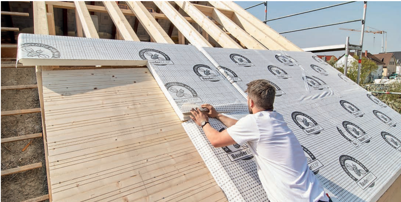
Unterm Dach schlummert vielfach noch ungenutzter Wohnraum. Ein Ausbau bildet eine gute Gelegenheit, dies mit einer wirksamen Wärmedämmung zu kombinieren. (Foto: DJD/Paul Bauder/www.michaelgallner.com)
