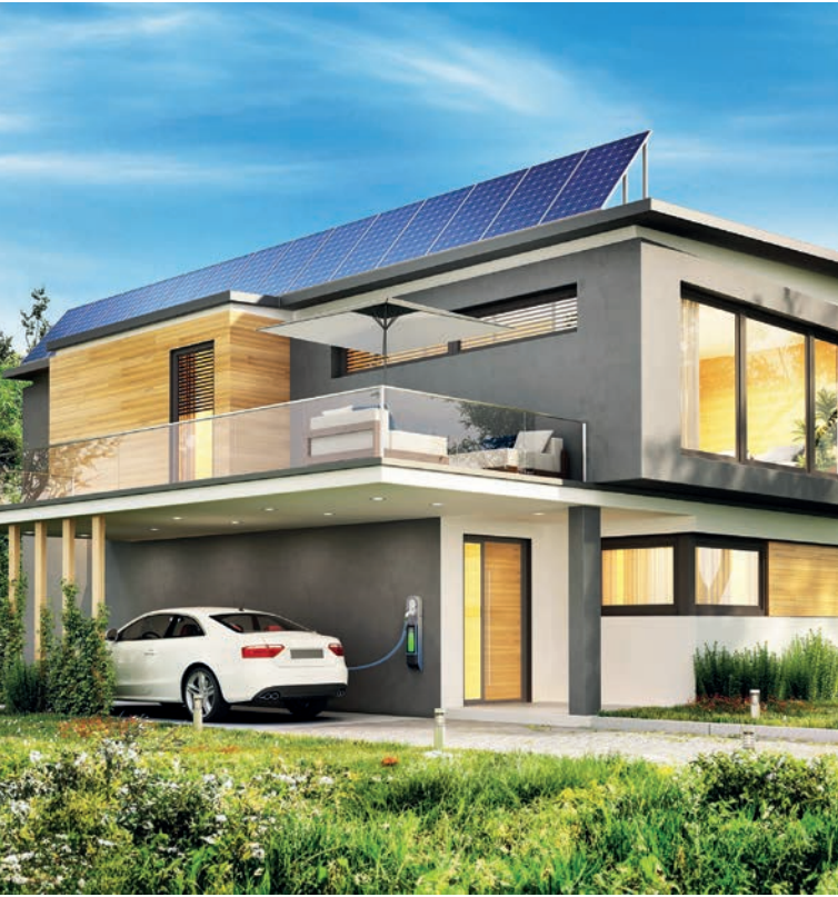
Zertifizierte Sicherheitstechnik sorgt dafür, dass Gefahren im Haus frühzeitig erkannt werden und die Eigentümer im Ernstfall schnell reagieren können. (Foto: djd/Telenot)
