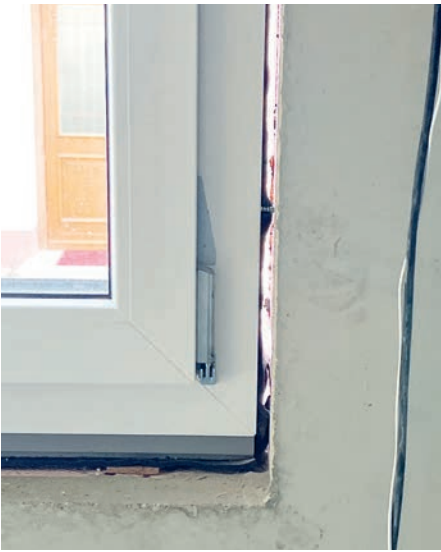
Undichtes Fenster
