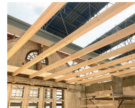
Dachsanierung Wolgast Schule
